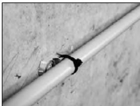
Эластичные или жесткие кабель-каналы с кабельными стяжками
