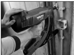
Крепление жесткого кабелепровода
