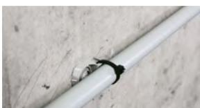
Эластичные или жесткие кабель-каналы с кабельными стяжками
