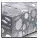
Бетон (без трещин)
